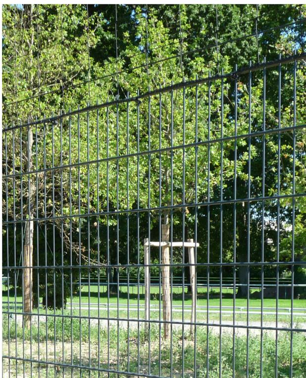
Les panneaux en treillis soudés sont renforcés par **des doubles fils horizontaux** donnant ainsi sa très grande rigidité à la clôture.
