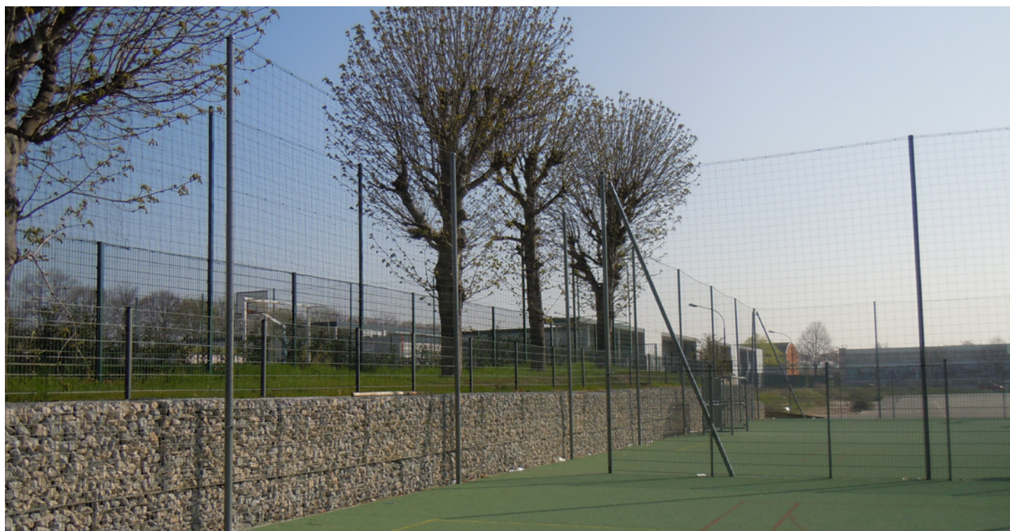
Poteaux ø 60 mm, ép. 2 mm
