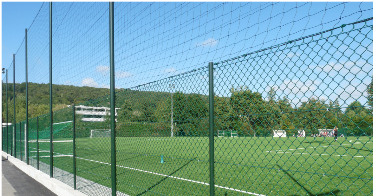
Poteaux ø 90 mm, ép. 2.5 mm
