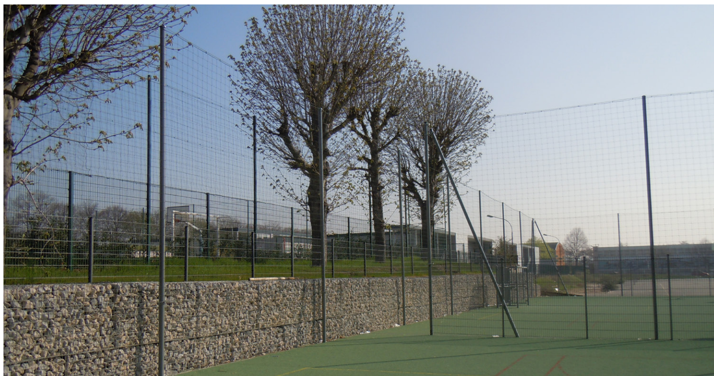
Poteaux ø 60 mm, ép. 2 mm
